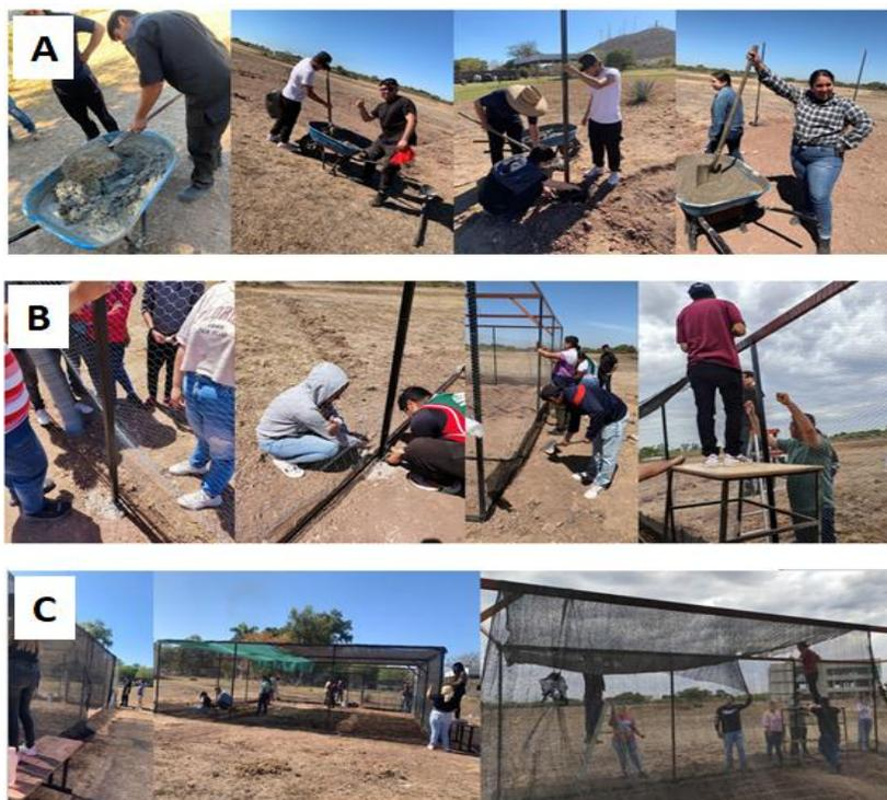
Figura 2. Proceso de construcción de la estructura del vivero. Colocación de cemento, malla pollera y malla sombra.
